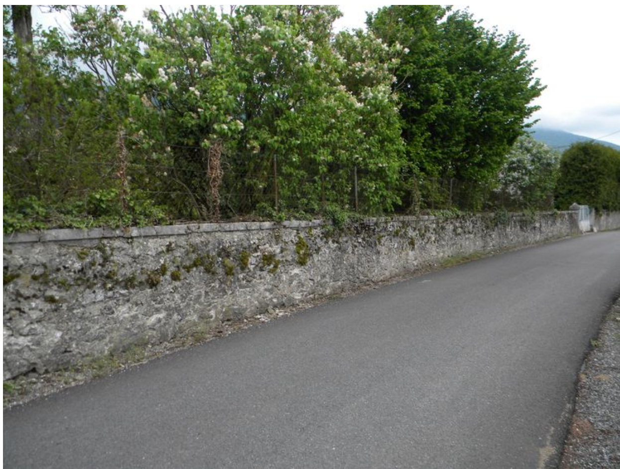
Vue du mur de clôture du parc de la maison bourgeoise.
