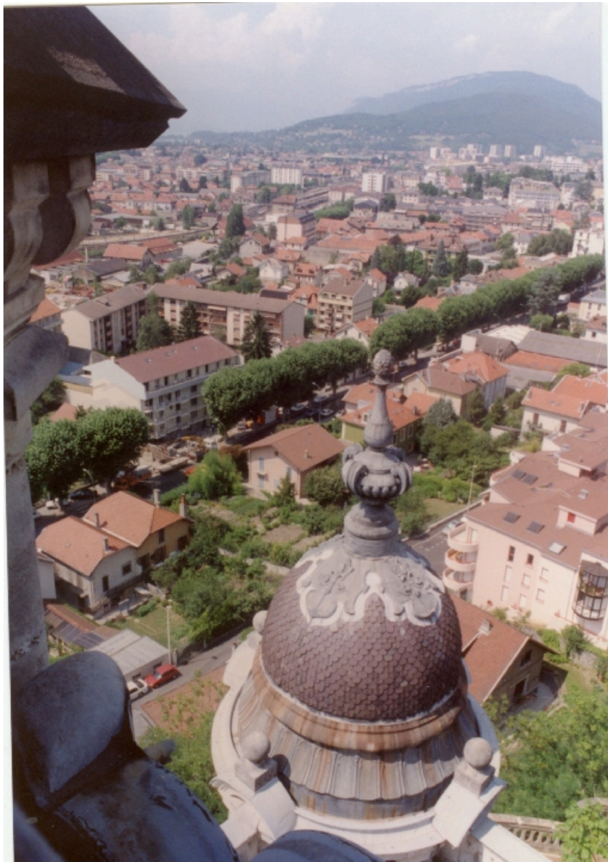
Couverture d'une tour d'angle
