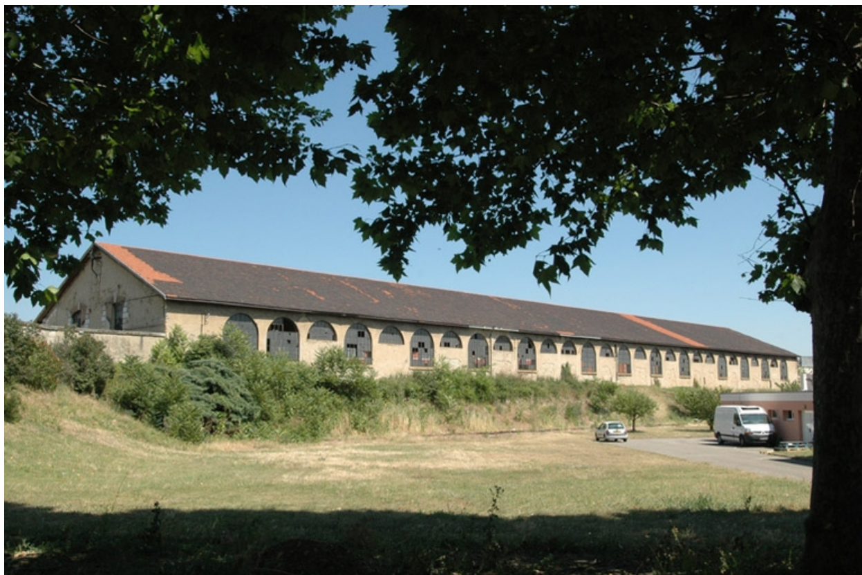
Vue d'ensemble de cette grande halle (bâtiment 76)
