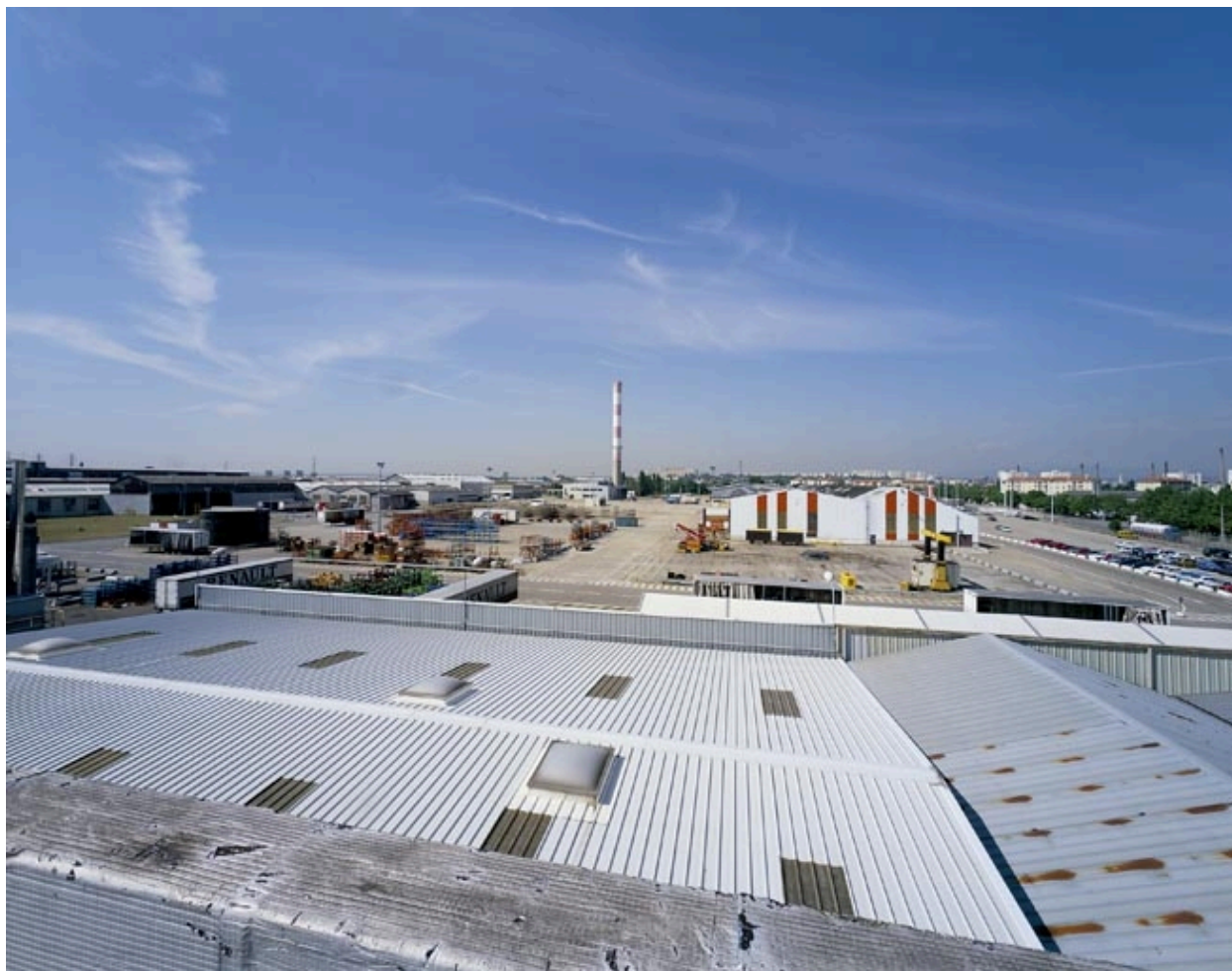
Vue d'ensemble nord de l'usine.
