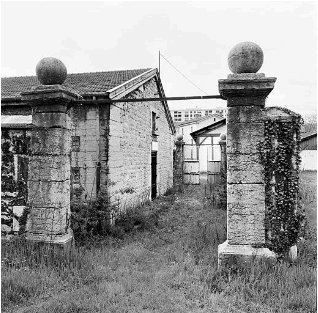
Vue du mur d'entrée depuis un des portails
