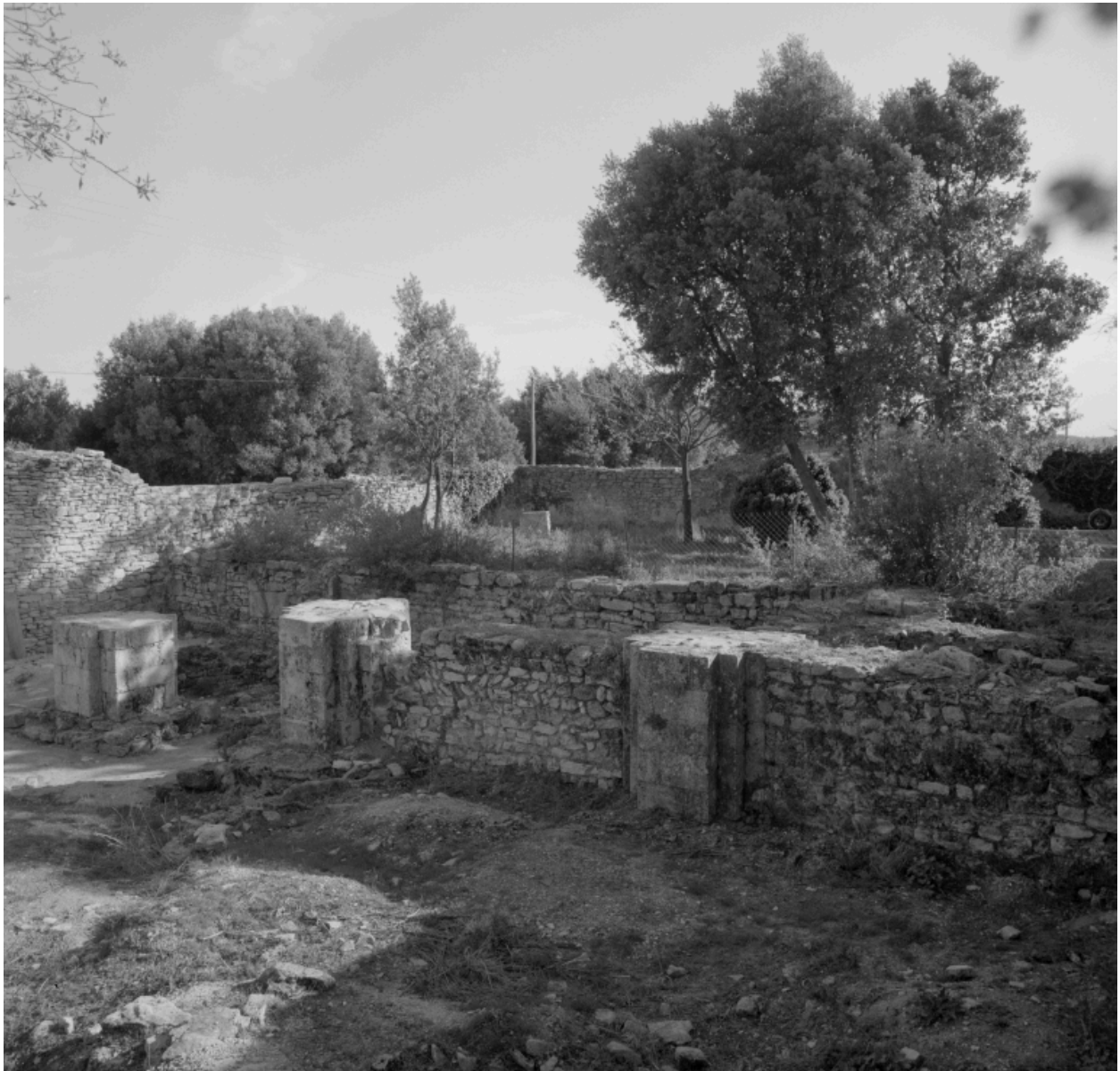
Vestiges des piliers sud de la nef de l'église romane.
