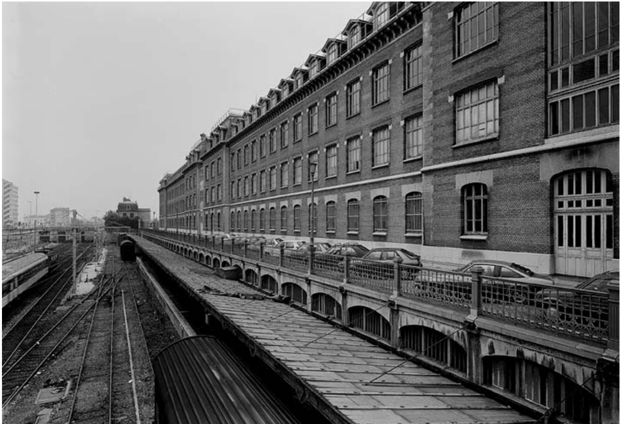
Façade ouest des bâtiments d'exploitation avec embranchement de la voie ferrée
