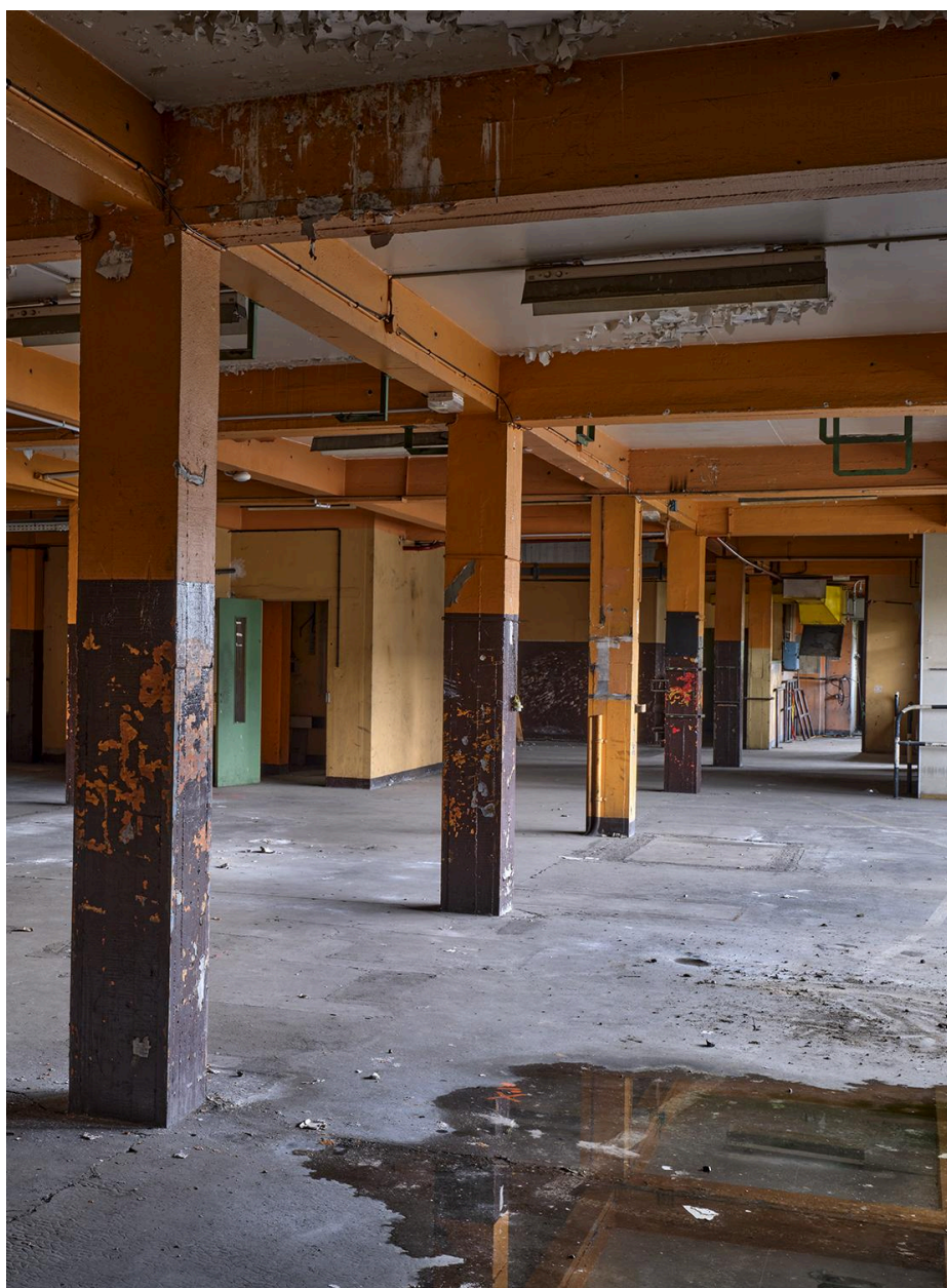
Détail intérieur de l'atelier O26, désaffecté.
