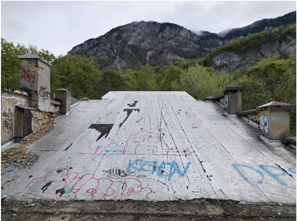
Auvent abritant la rampe d'embarquement
