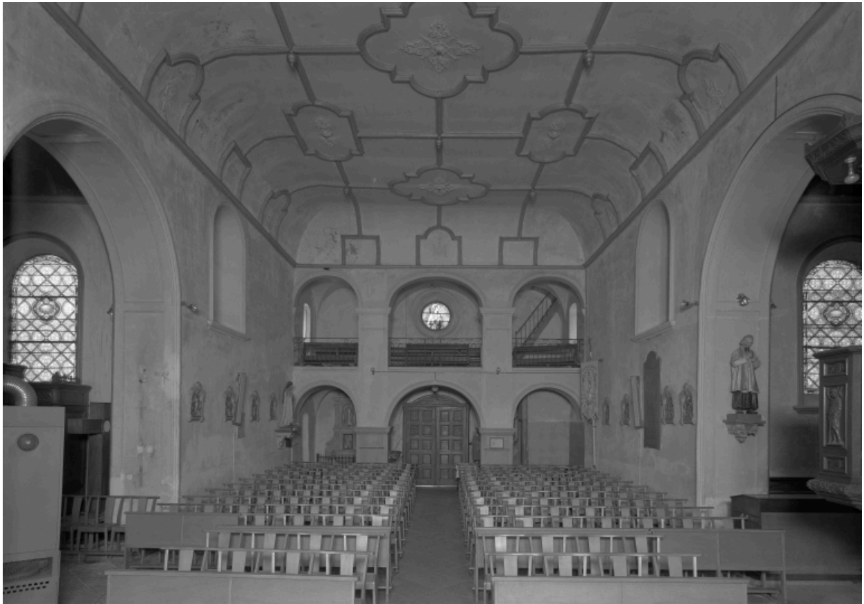
Vue d'ensemble intérieure de la partie ouest de l'église.
