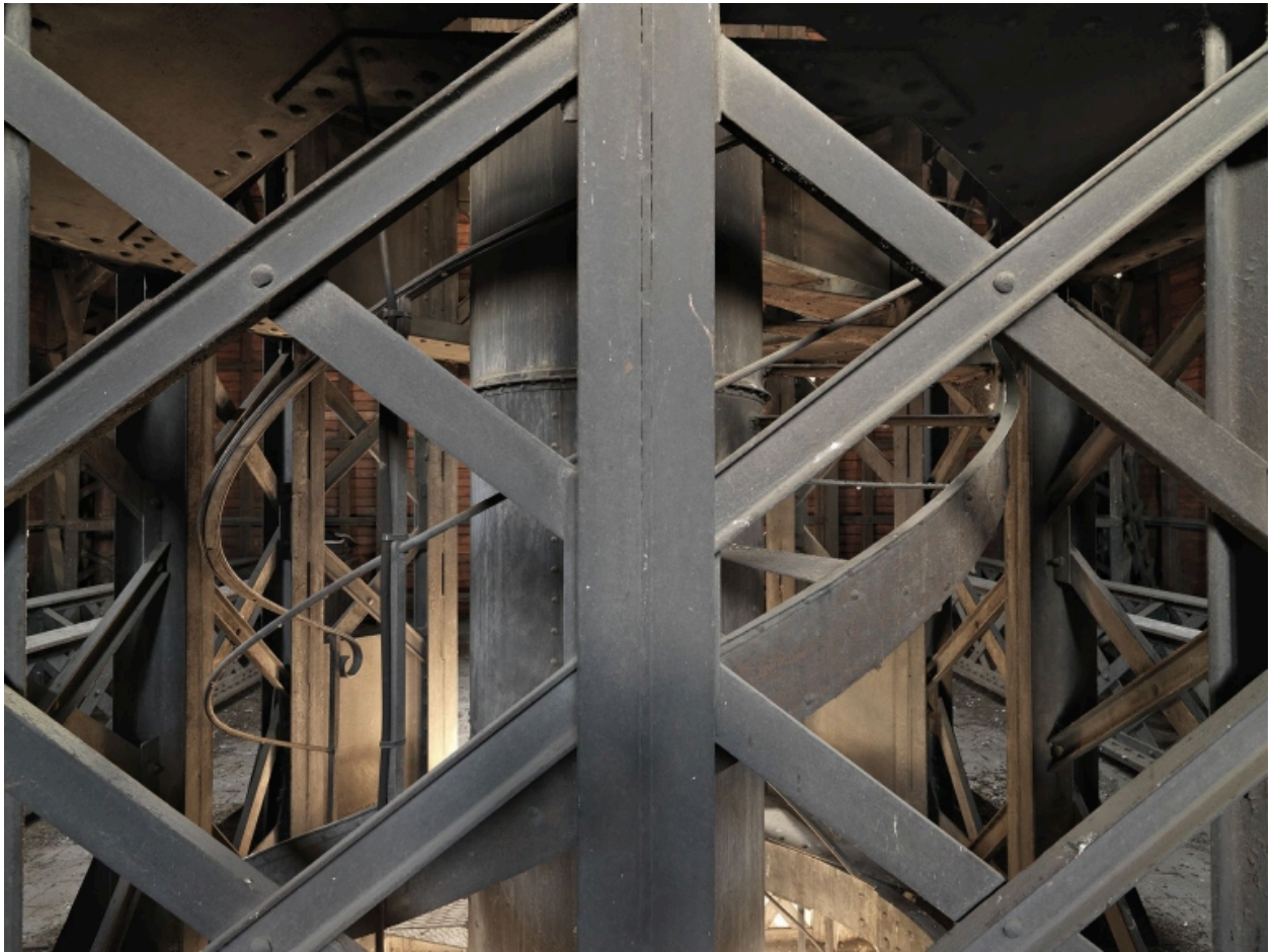
Le dôme Pascalon. 2e étage. Détail de la cage d'escalier
