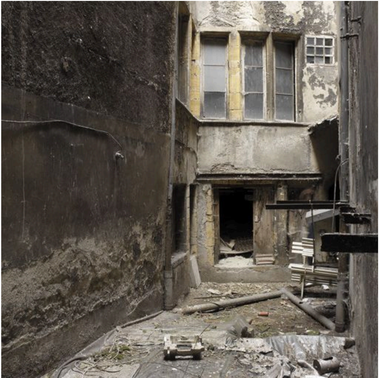
Bâtiment 4, vue des deux premiers niveaux
