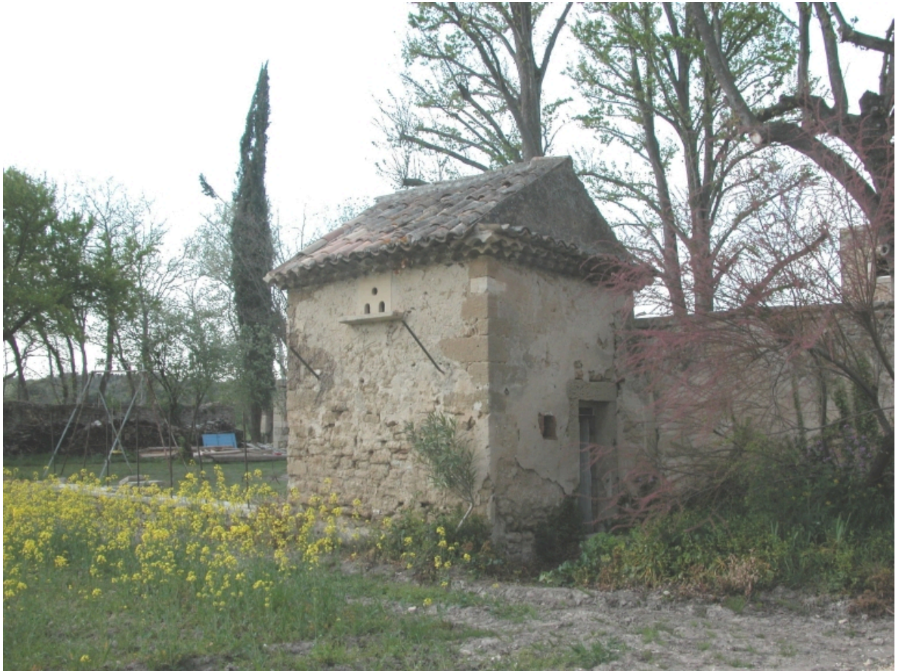
Vue du pavillon d'entrée orienté à l'est.
