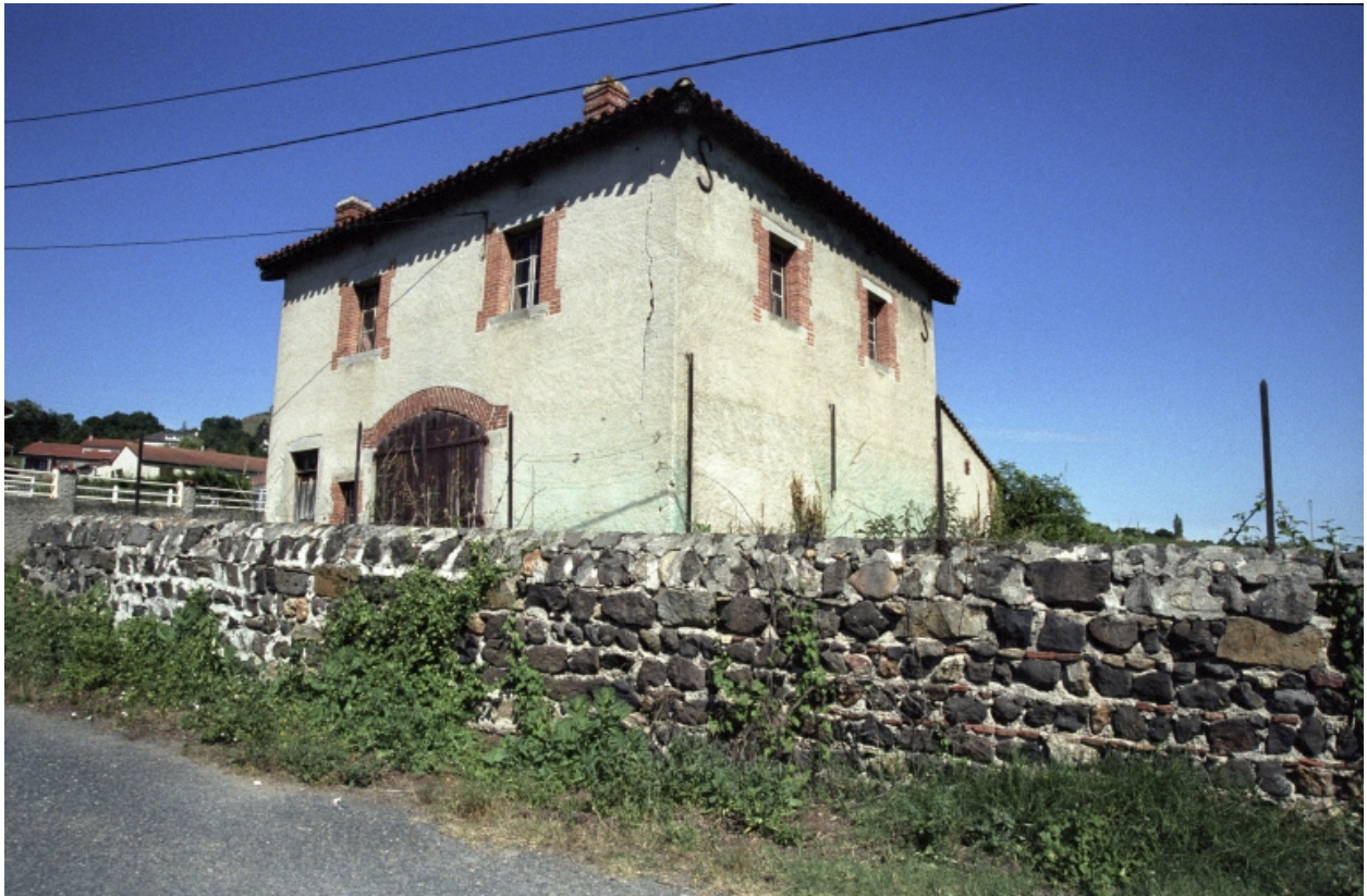
Marcilly-le-Châtel, le Ravat, parcelle 1987 A1 199. Vue d'ensemble de trois quarts.
