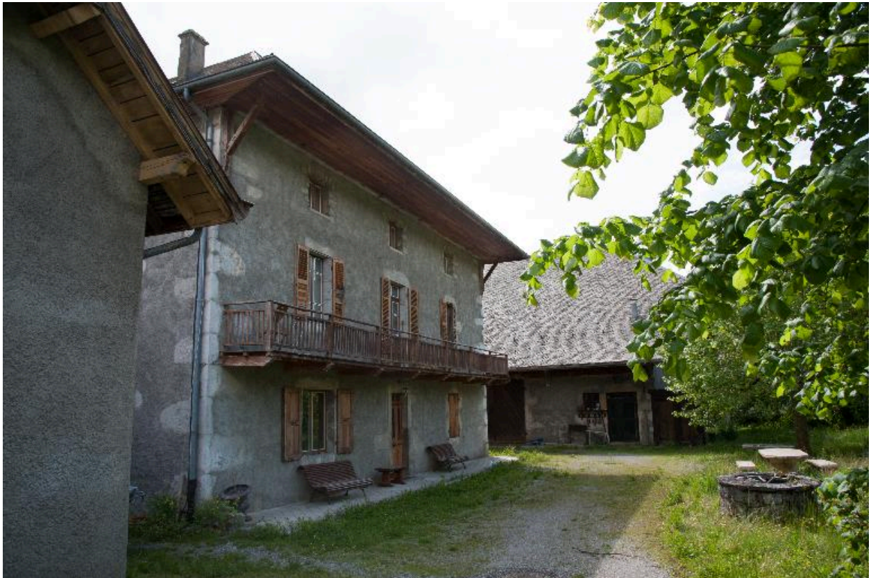
Vue de la façade arrière depuis la cour.
