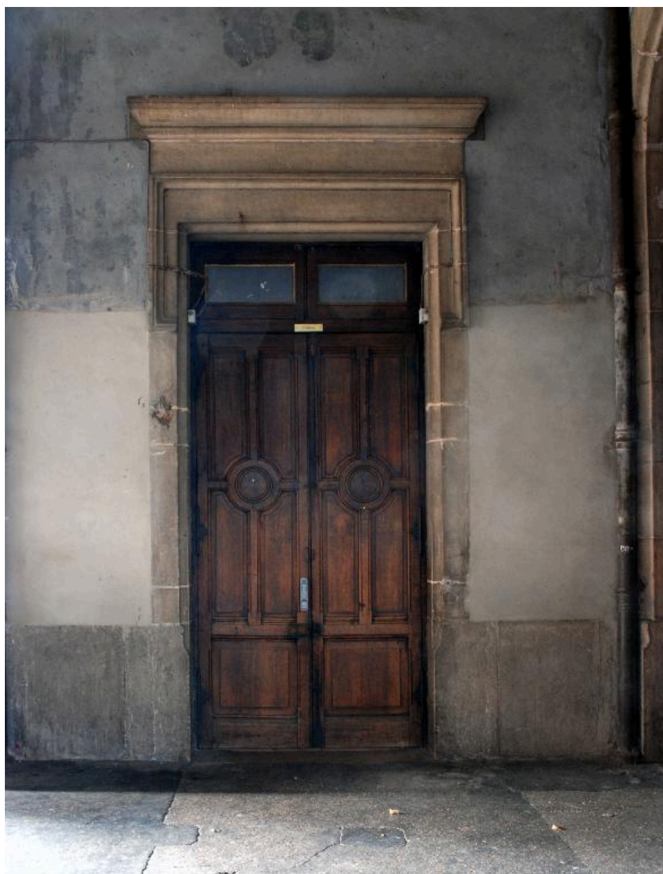
Cour, galerie sud-ouest, détail d'une porte
