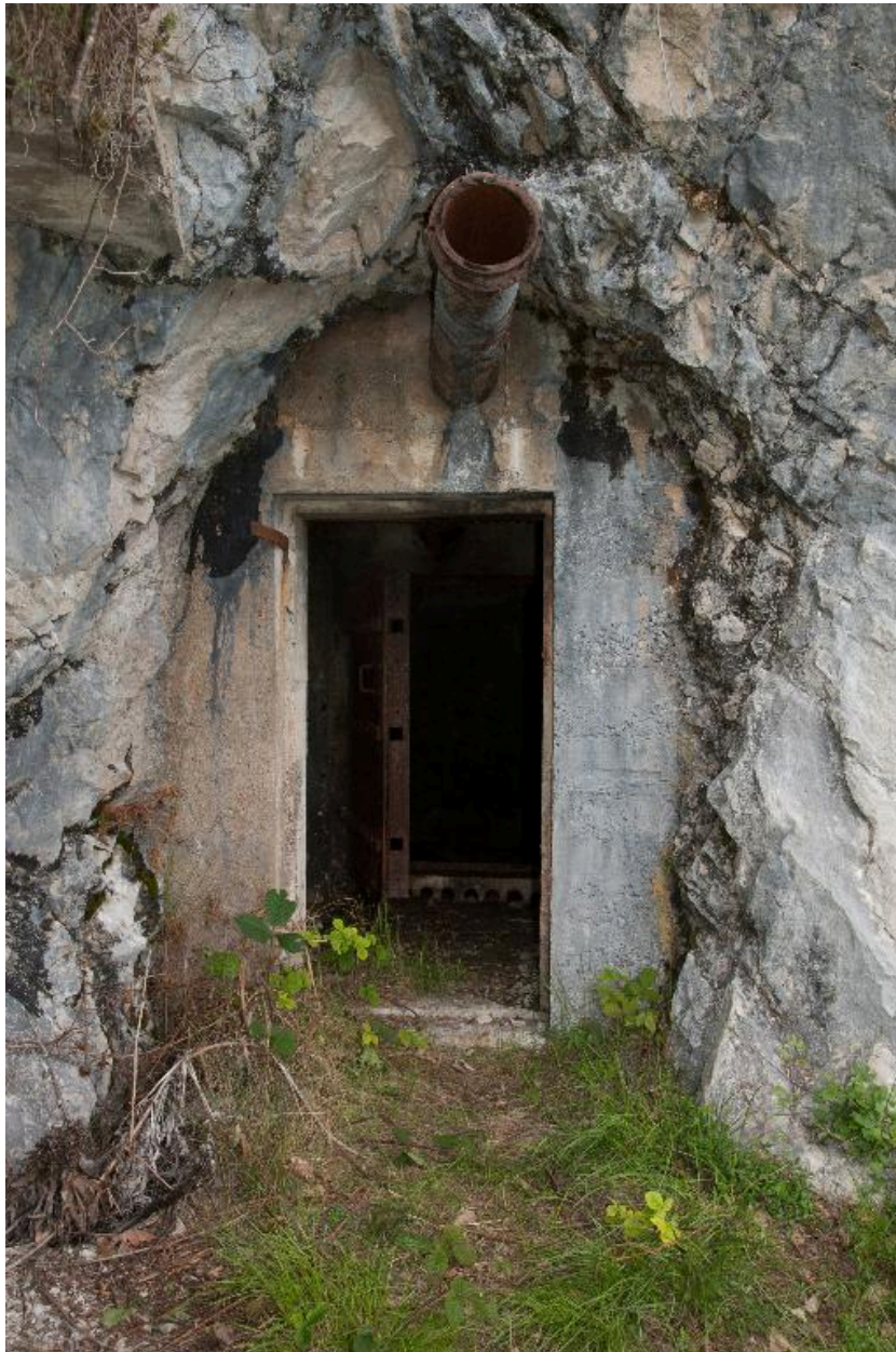
Vue de l'entrée de la galerie de la Poudrière.
