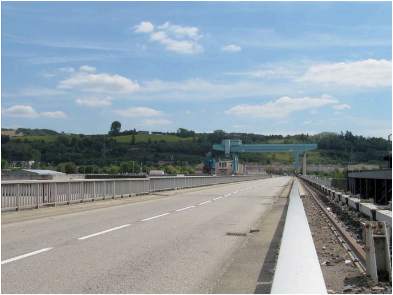
Pont routier, vue partielle : chaussée (depuis la rive droite)
