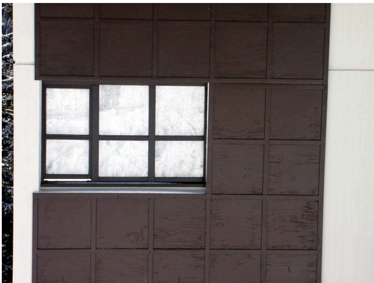
Détail de la baie du 2e étage, élévation nord, partie est
