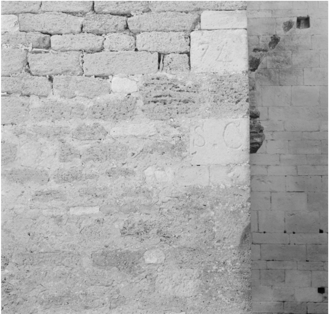
Détail des inscriptions 74 et S.C. sur des pierres changées au XIXe siècle sur le bâtiment nord.
