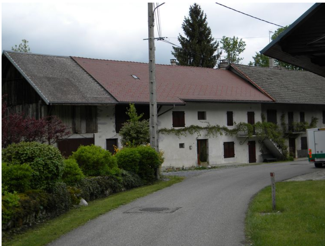
Vue générale de l'ancien martinet Bertholio en venant de la Combe d'Ire.
