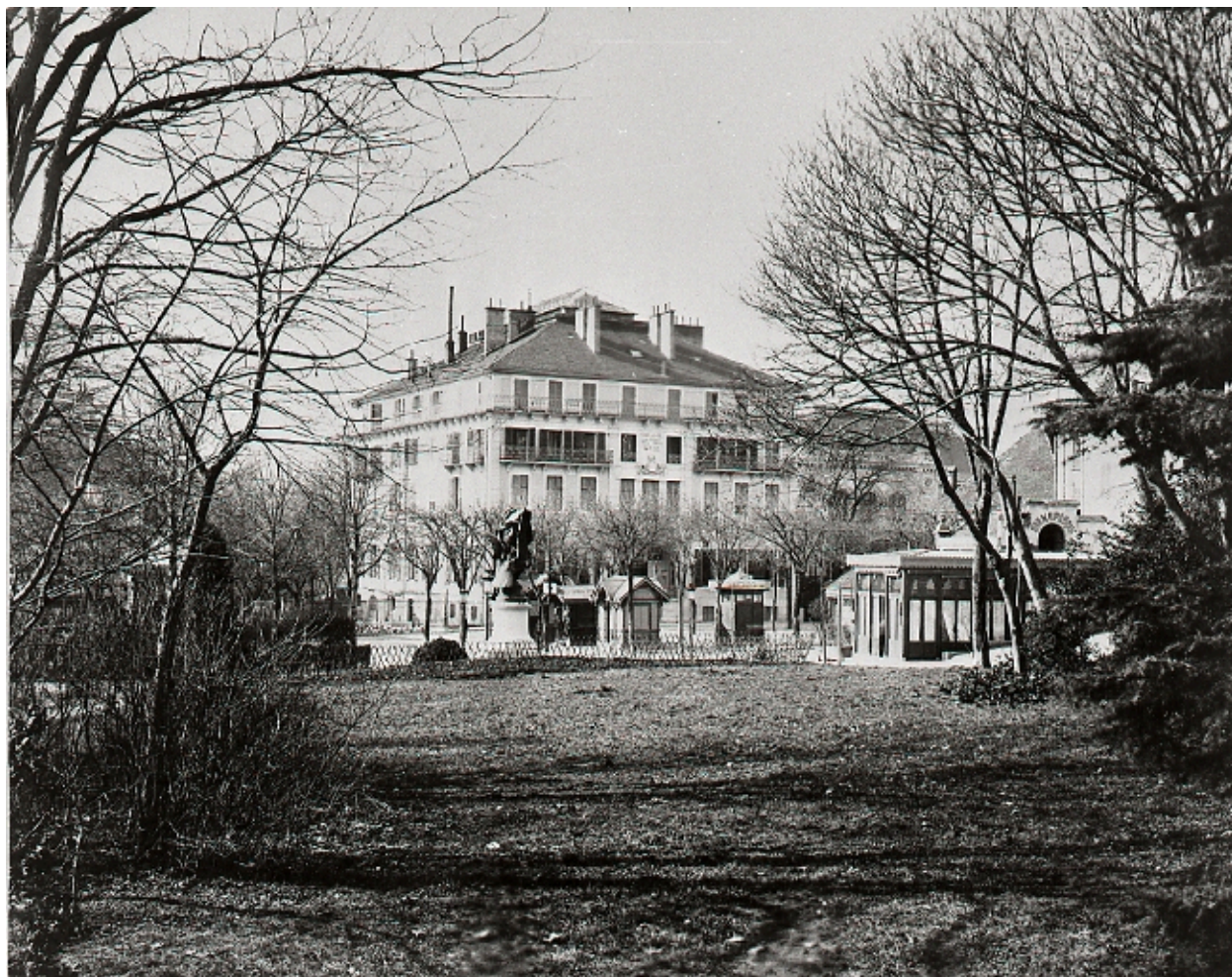
Vue d'ensemble avant transformation
