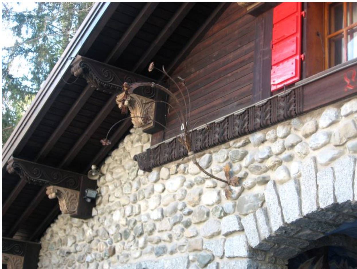
Les consoles supportant l'avant-toit
