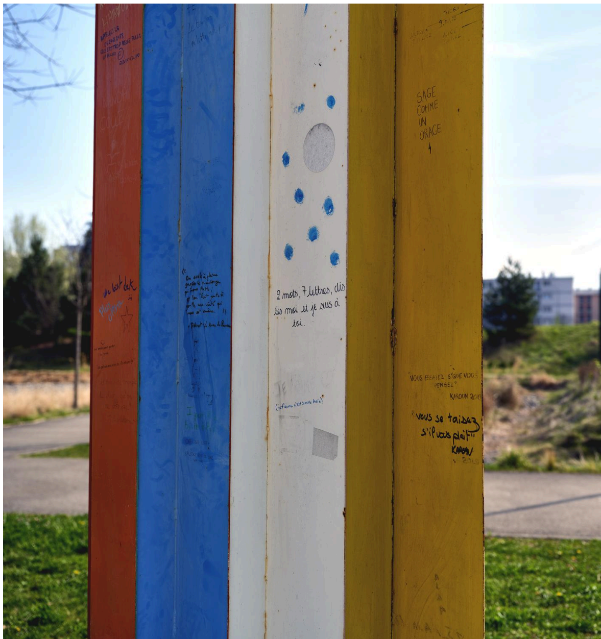
Détail des altérations, partie latérale gauche, face interne
