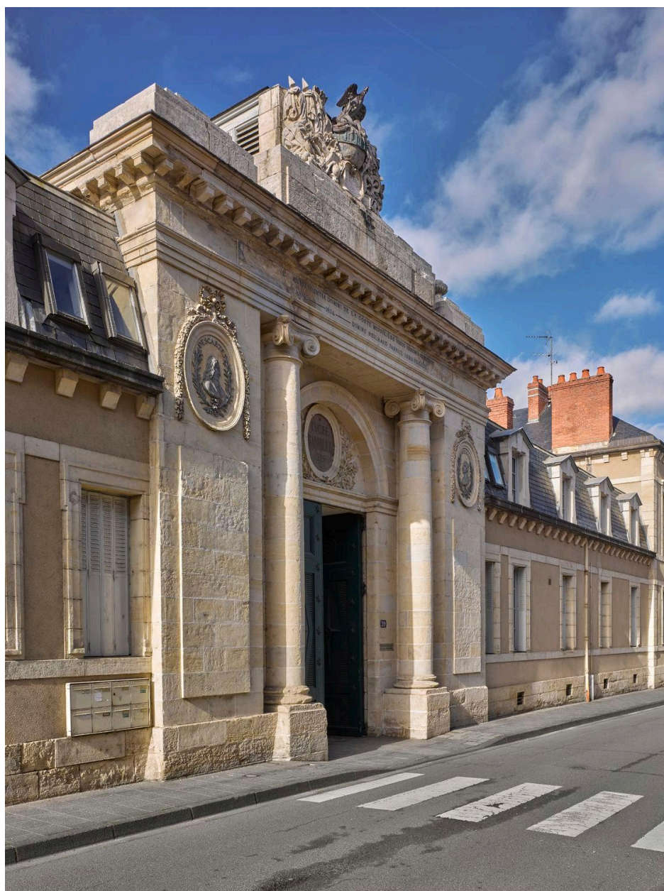
Façade sur la rue de Paris. Porche d'entrée.
