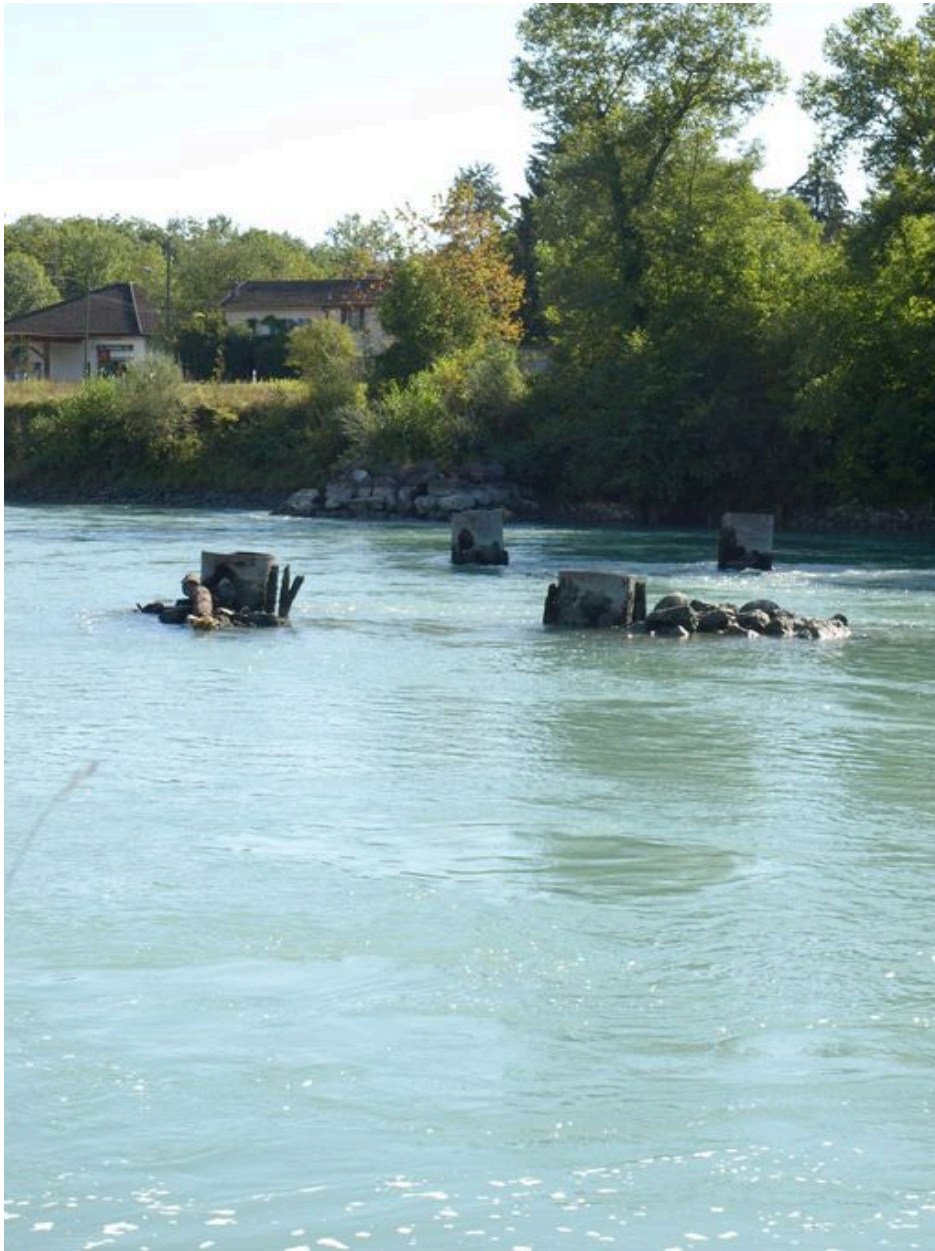
Vestiges de piles du pont à poutre droite en treillis, face aval (depuis la rive droite)
