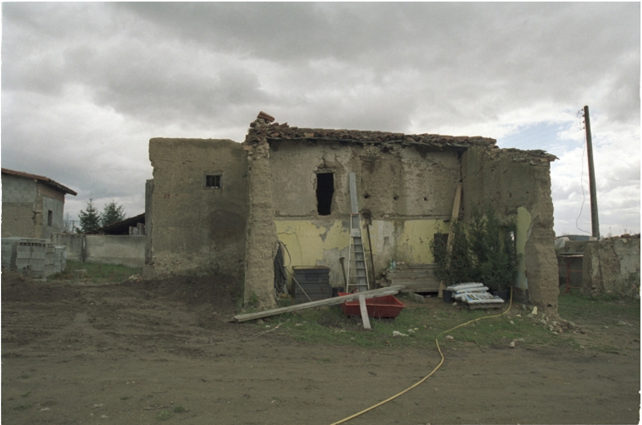
Vue d'ensemble de l'élévation postérieure du logis (fin 2000).
