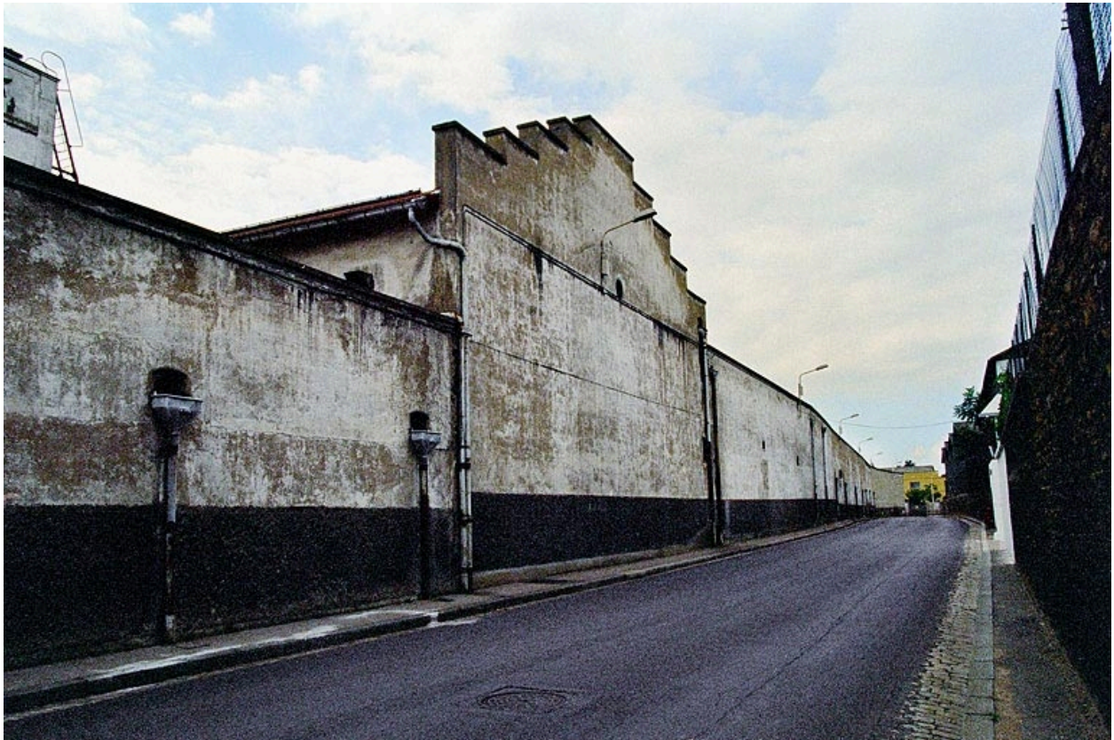
Suite façade ouest en alignement de la rue Joannès Carret
