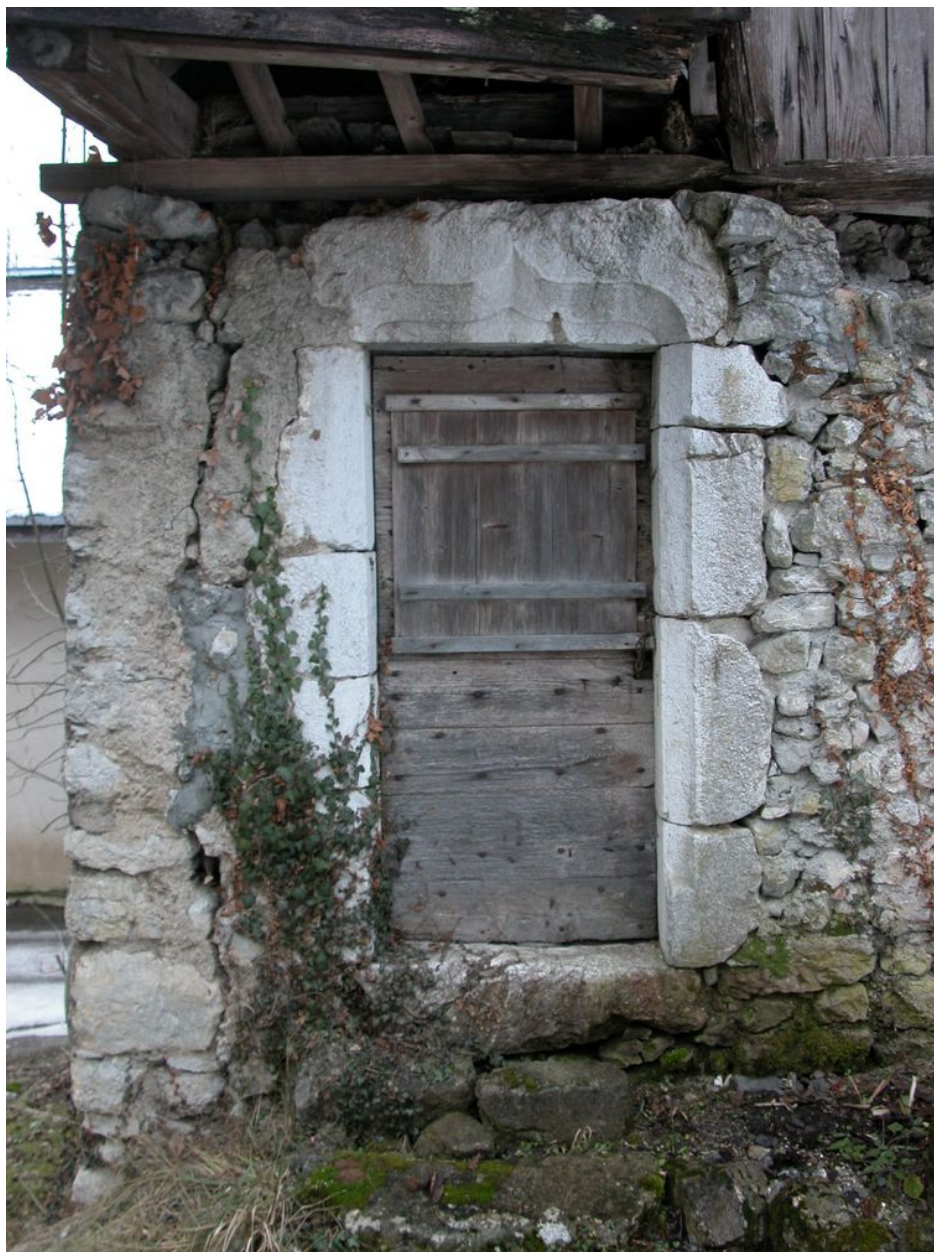
Porte avec accolade en façade arrière.
