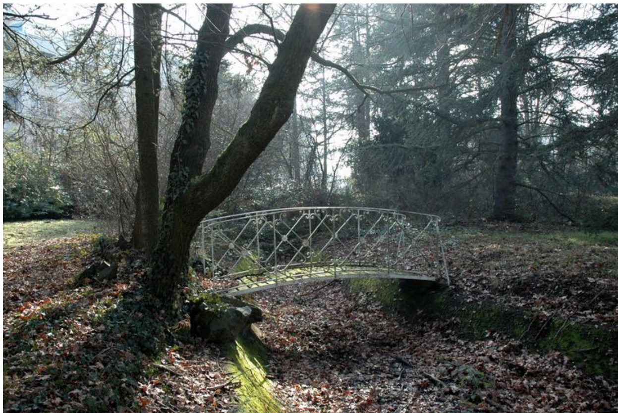
Vue du pont de jardin
