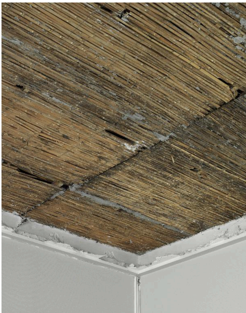
Le pavillon H en 2015 (en cours de déconstruction) : détail du plafond avec "lattis" en roseau (au nord, côté cour anglaise)
