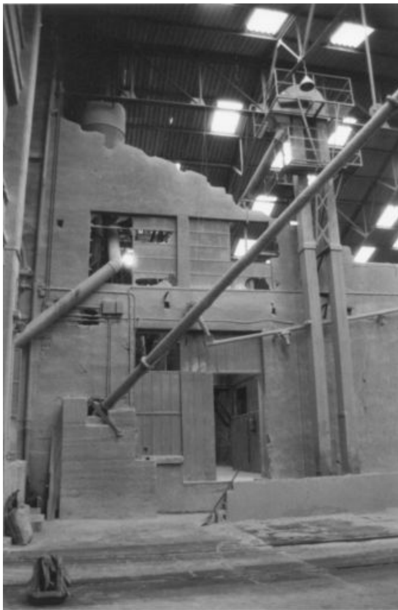
Passage trémie, vue intérieure
