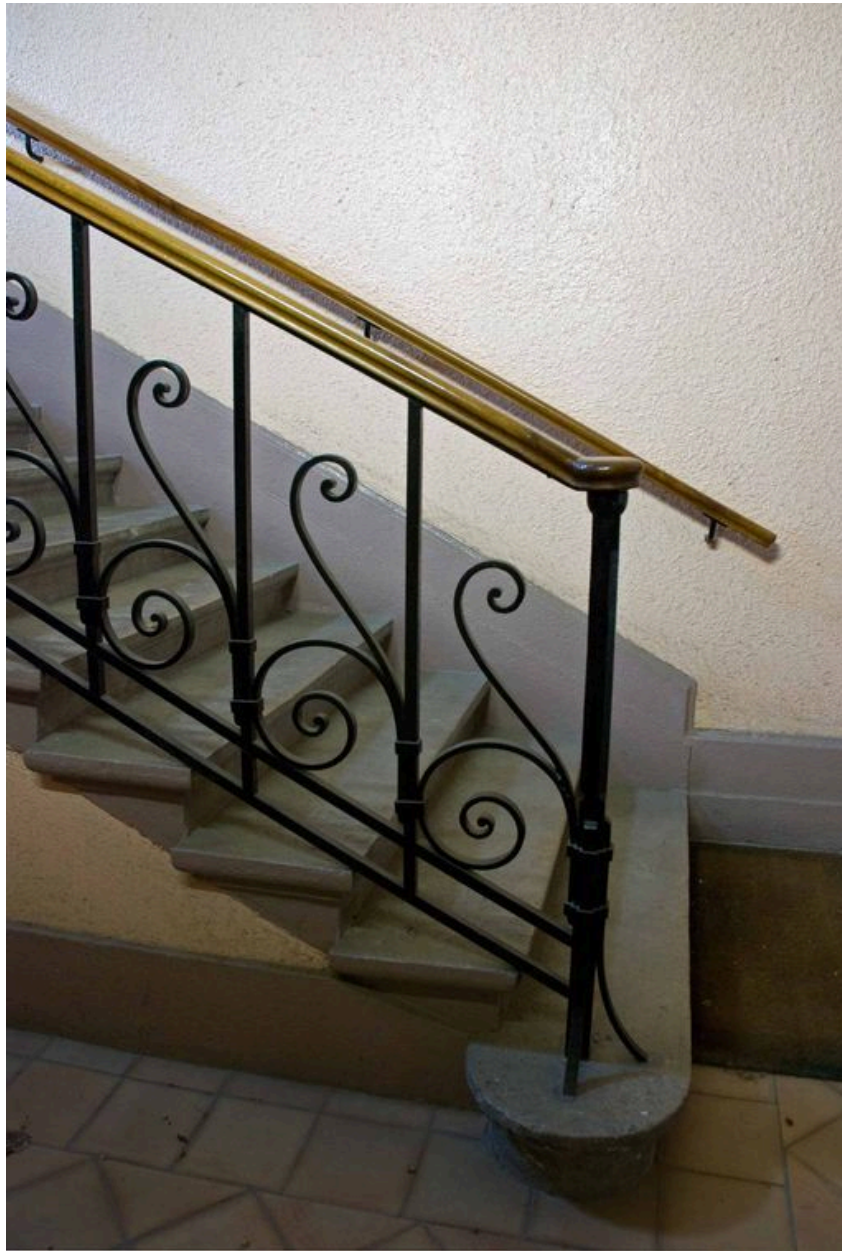
Escalier nord, détail de la rampe
