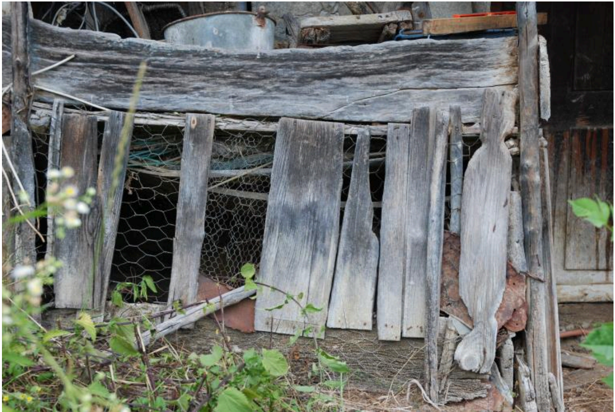
Détail de mise en oeuvre : fermeture du poulailler.
