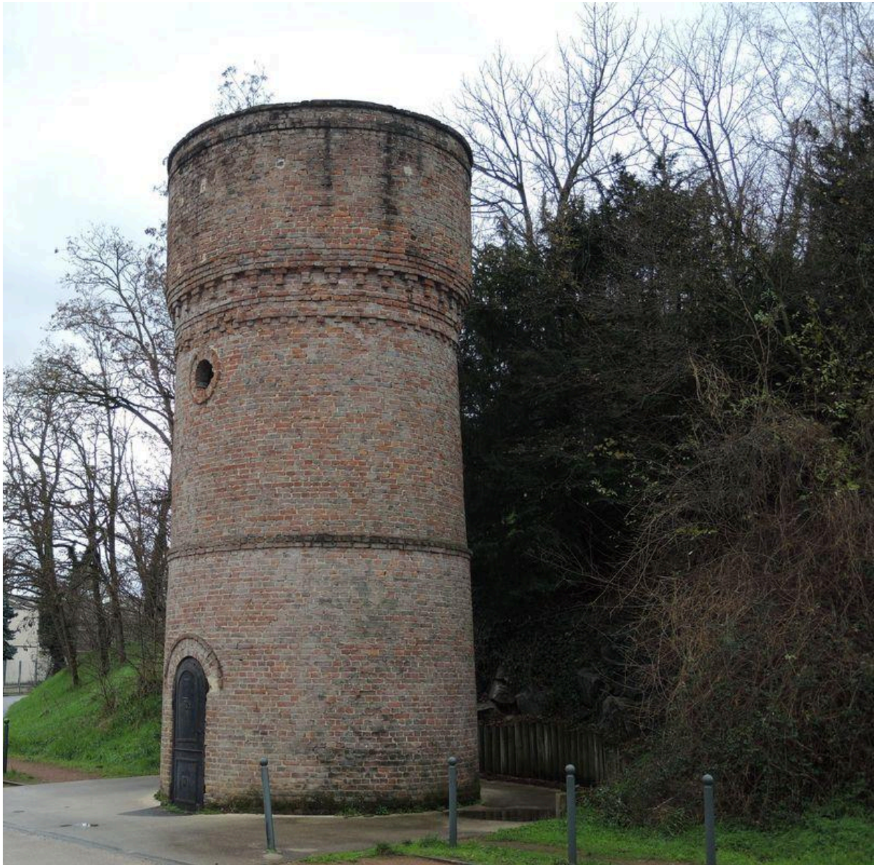
Château d'eau de la mine pour alimenter en eau le lavage et le criblage du charbon
