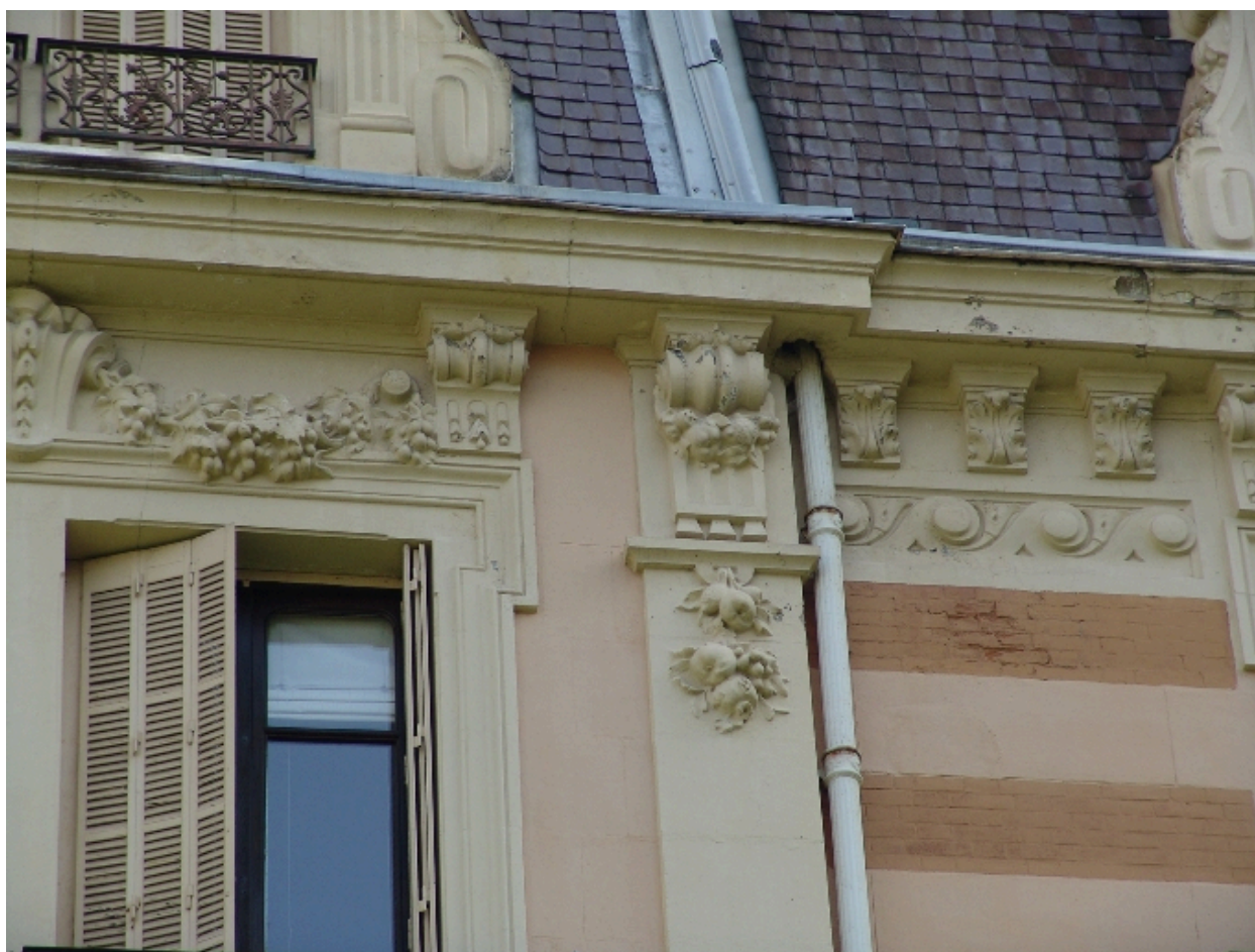
Détail du décor de la façade sud
