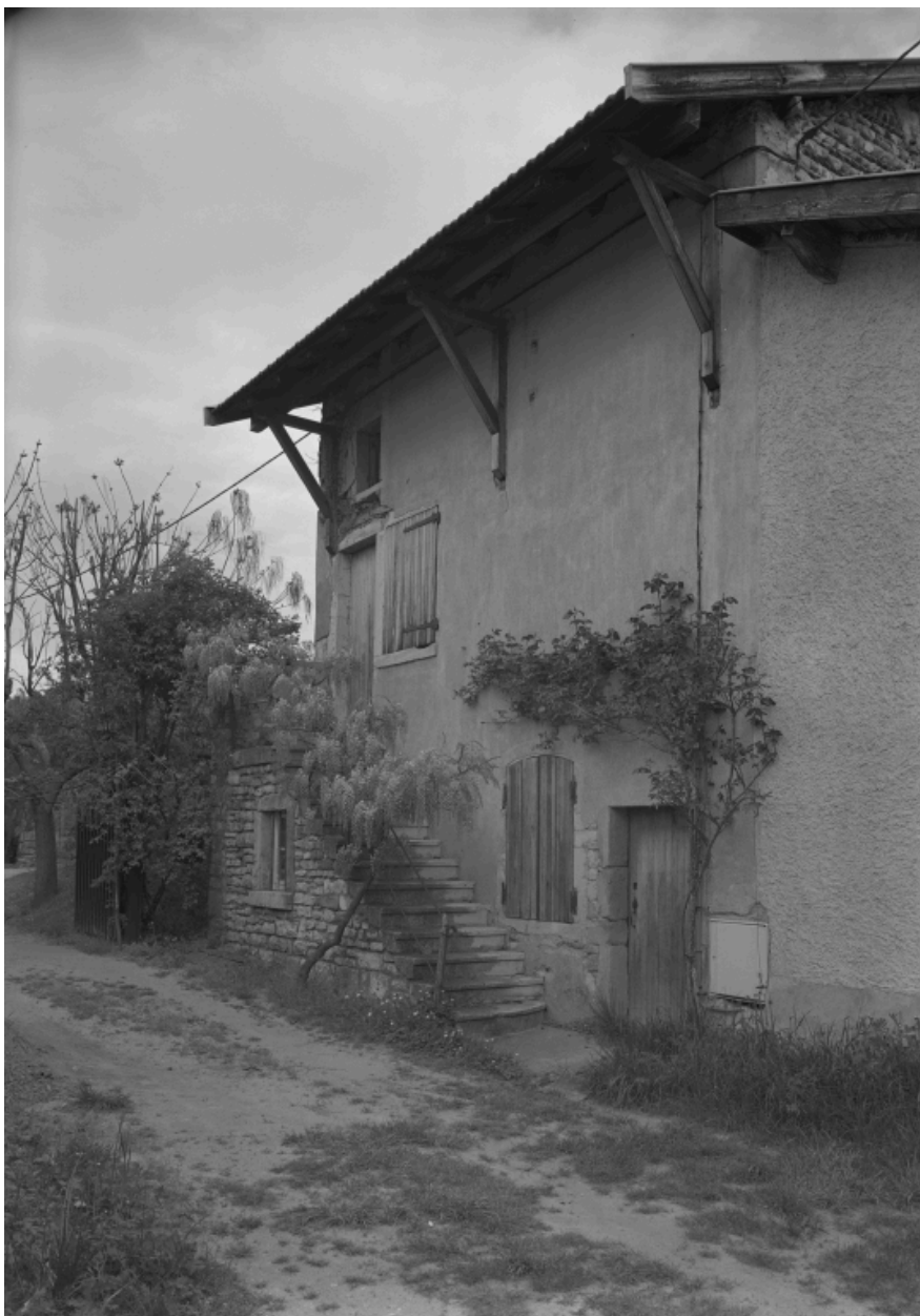
Maison de type I, Saint-Bernard, rue de la Saône : maison rurale en pisé, escalier extérieur couvert par l'avant-toit débordant sur aisseliers.
