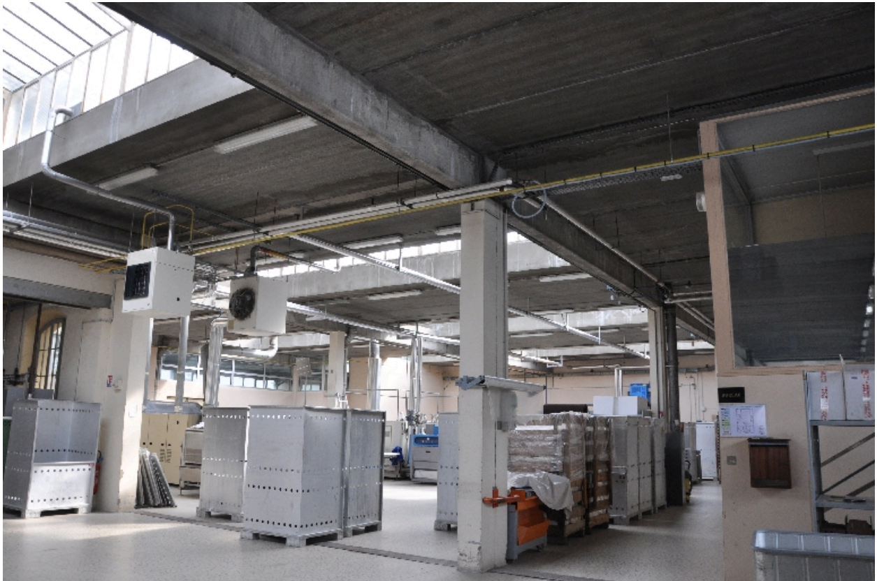
Extension de 1973, calandrage
