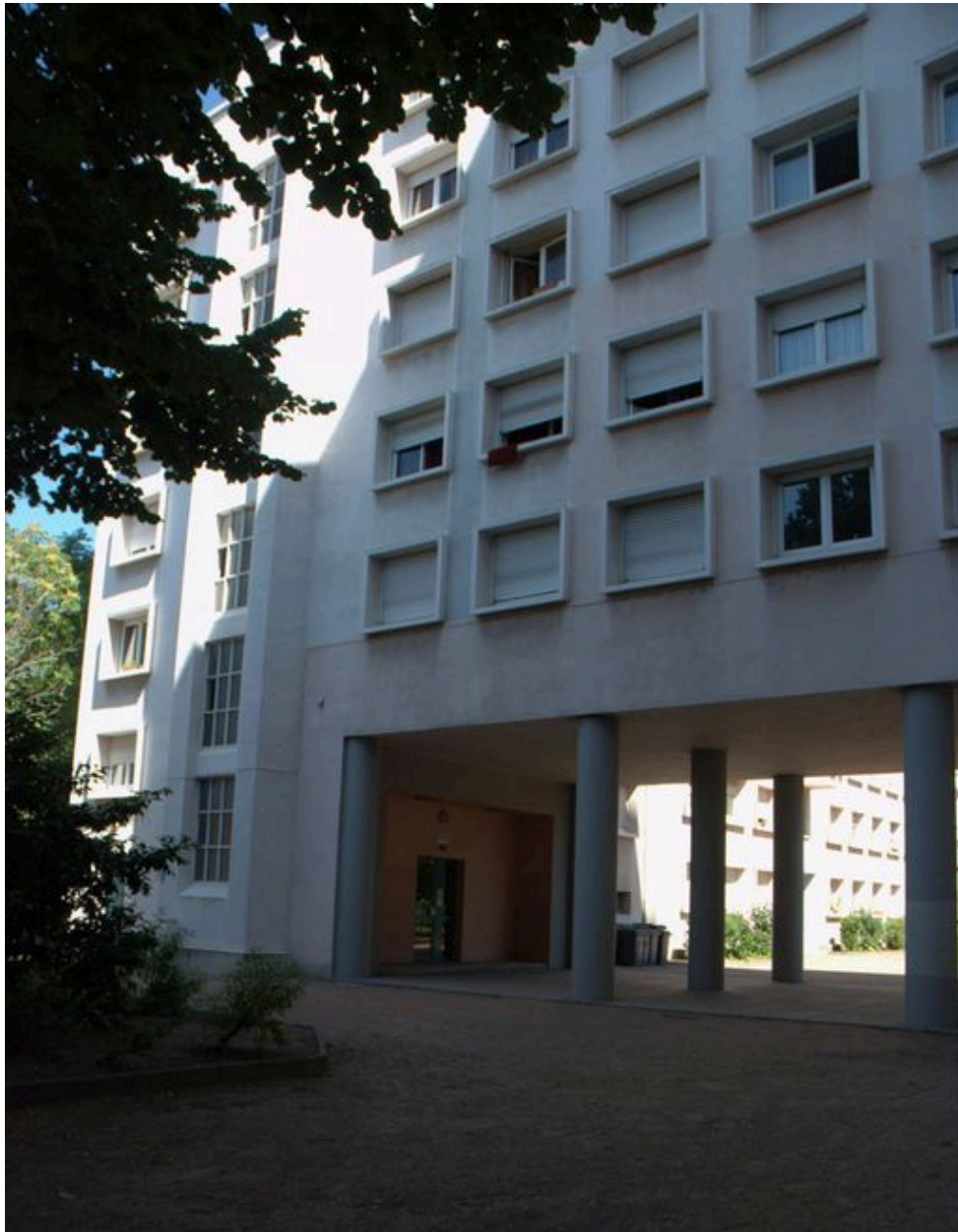
Immeuble n°64, élévation antérieure, vue partielle et portique
