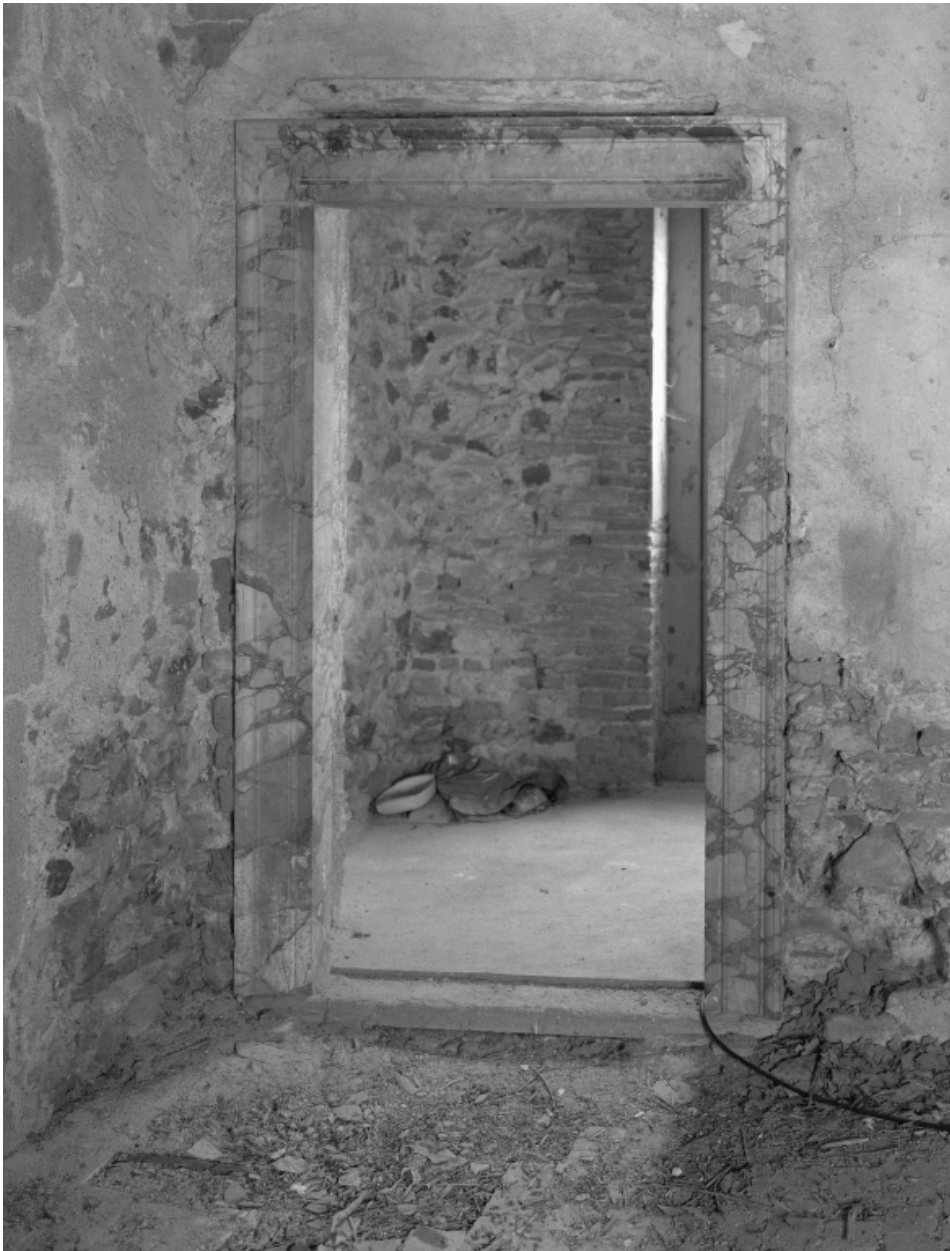
Corps de logis, deuxième étage, première pièce (d'est en ouest), corridor : détail de la quatrième porte aux chambranles de marbre, du nord.
