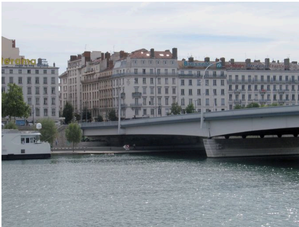
Vue partielle, travée gauche, face amont (depuis la rive droite)
