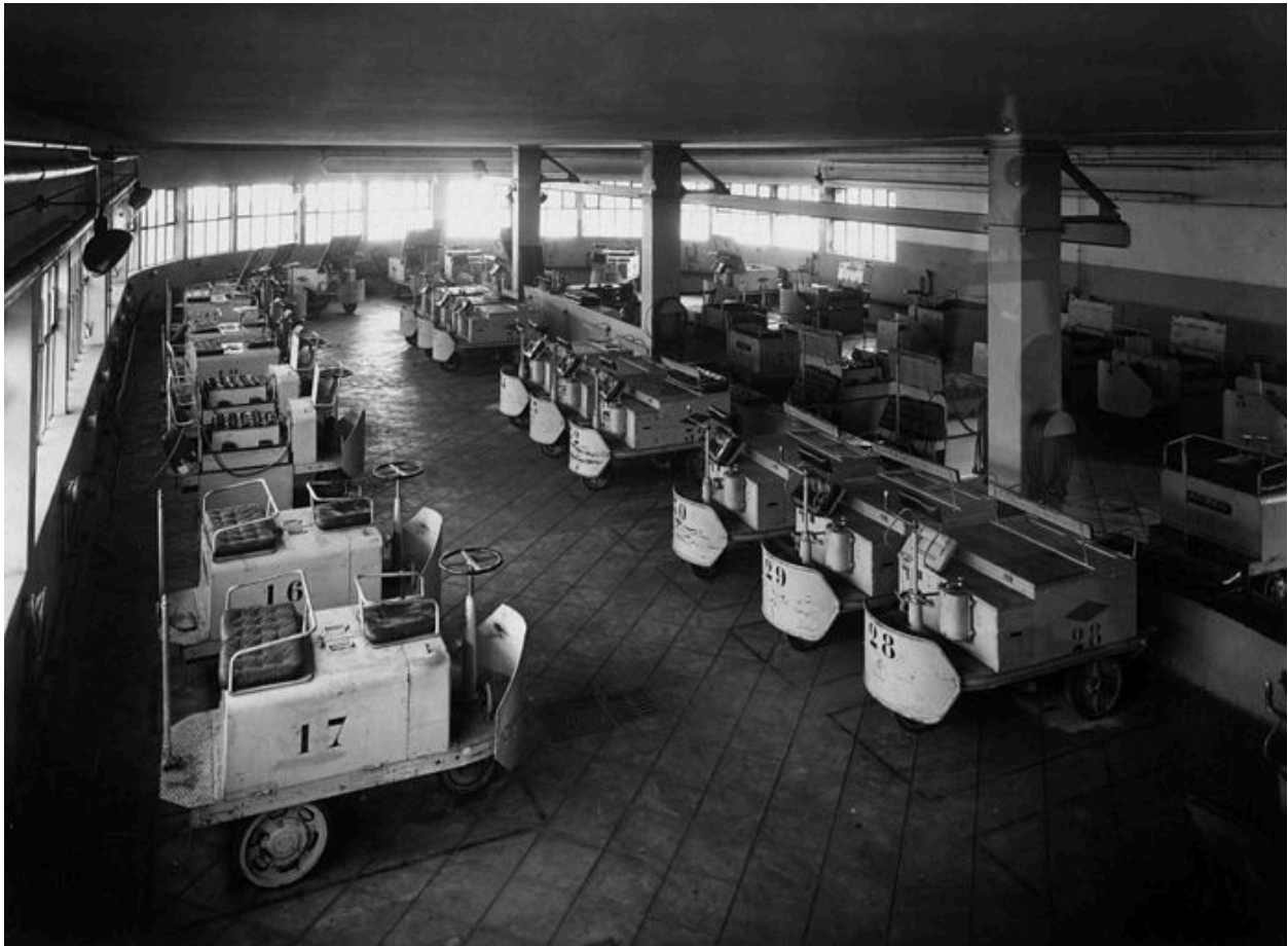
Bâtiment 9. Poste de charge des tracteurs. Photogr., Henri Aloy, 1958 ?
