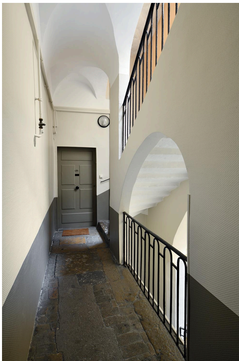
Escalier : palier voûté d'arêtes
