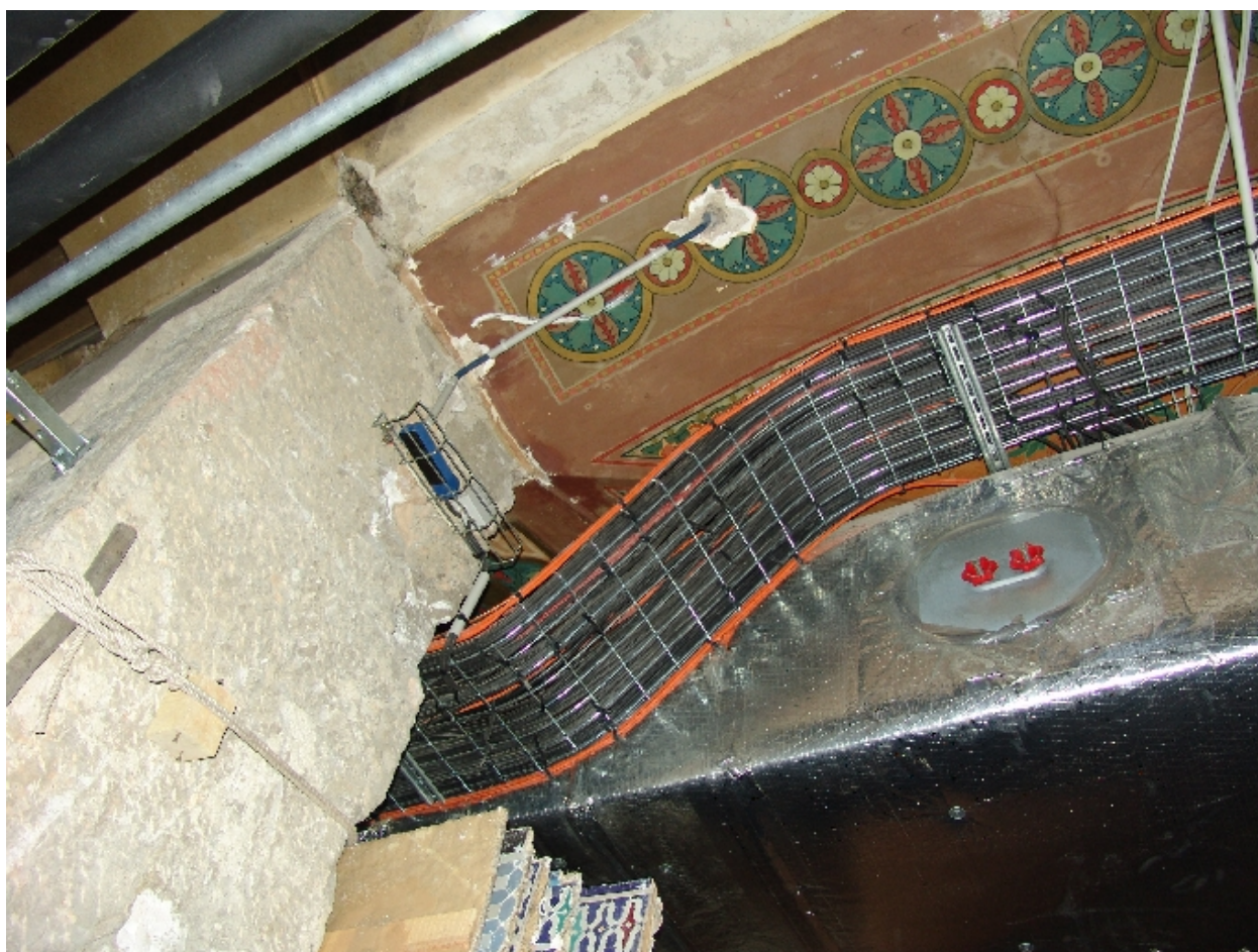
Etage de soubassement, partie technique ouest : décor
