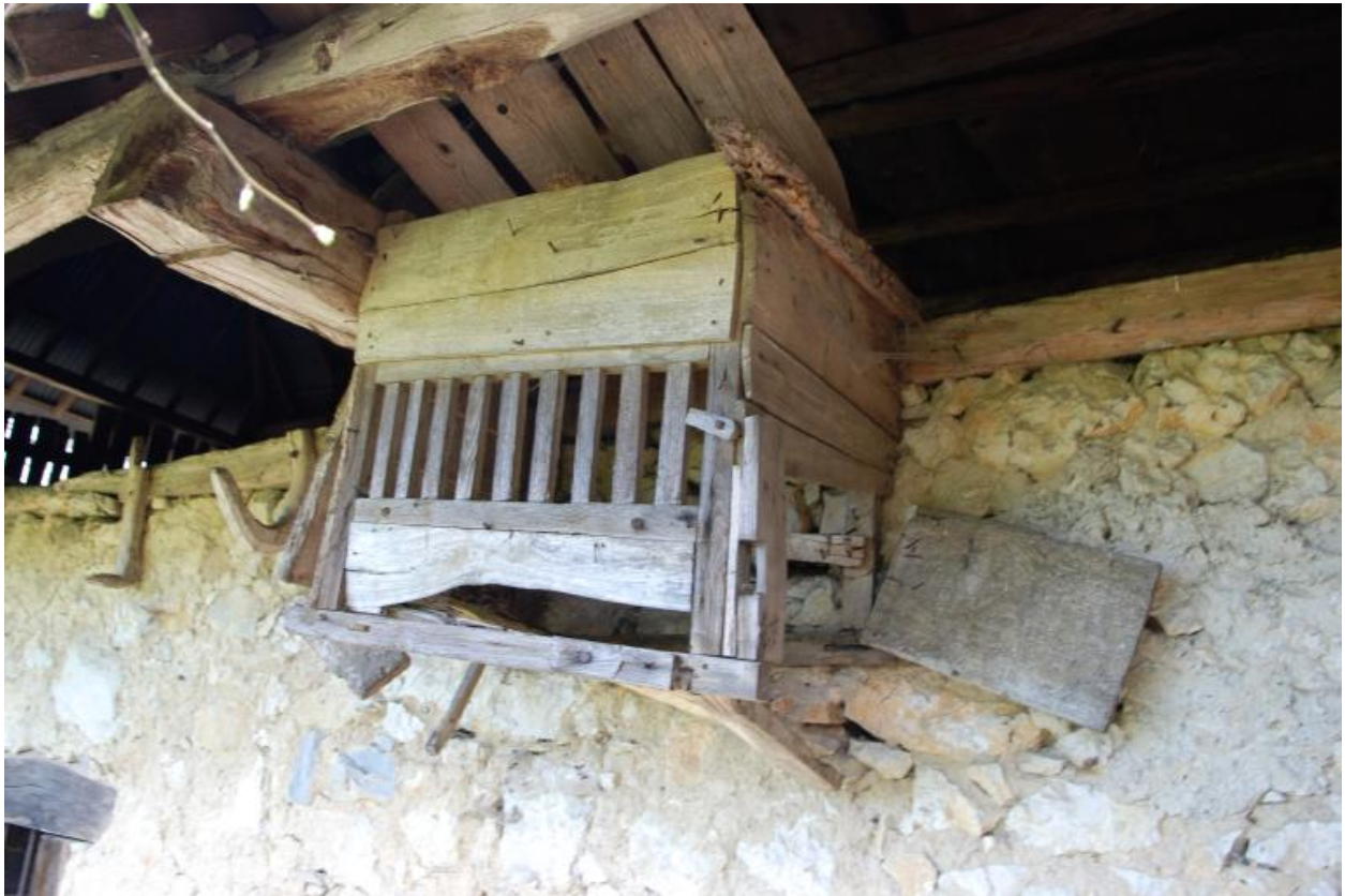
Vue d'ensemble d'une cage à oiseaux (?) en bois située sous l'avant-toit du mur gouttereau principal.
