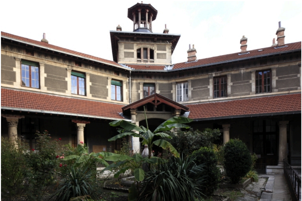
Cour G. Vue d'ensemble.
