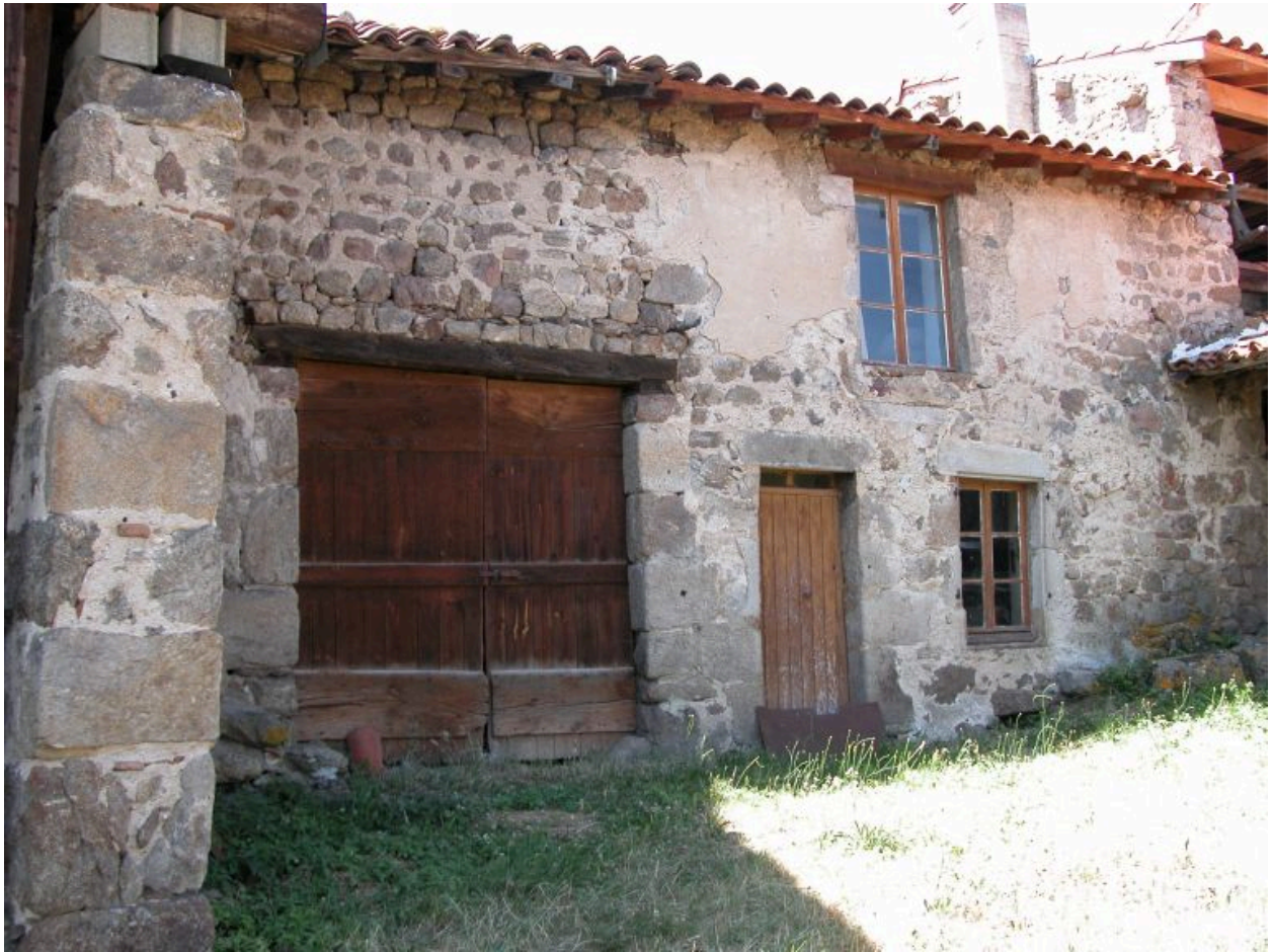
Vue d'ensemble de la partie droite de la ferme.
