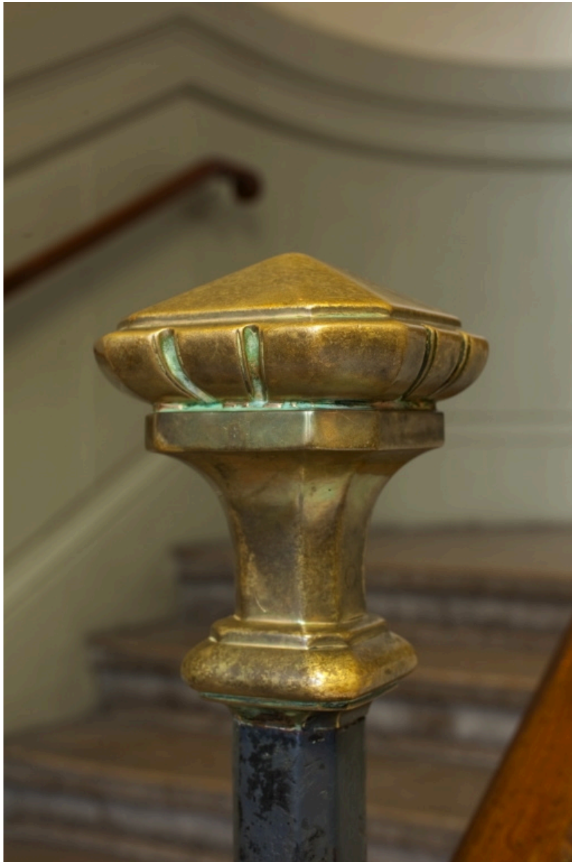
Escalier 1900. Détail du départ de la rampe.
