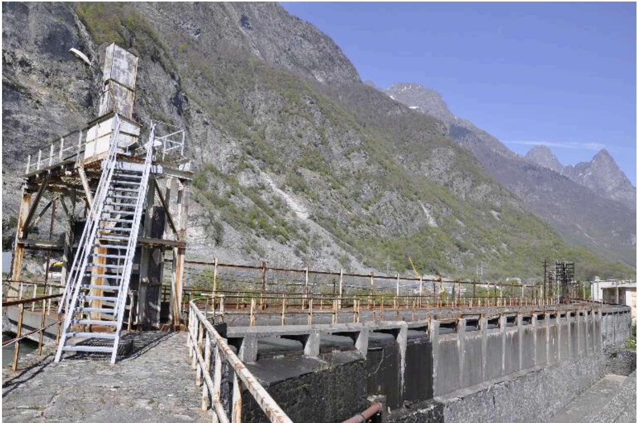
Vue du barrage
