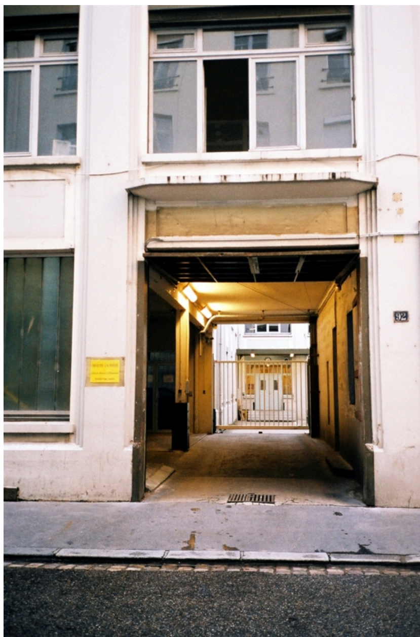
Entrée rue Montesquieu
